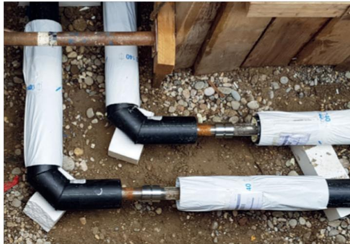
Bild 1. Das Verpressen einer Rohrverbindung dauert mit dem Haelok-Pressverbinder weniger als eine Minute und erfüllt die hohen Ansprüche an Dichtheit und Statik in der Fernwärme
