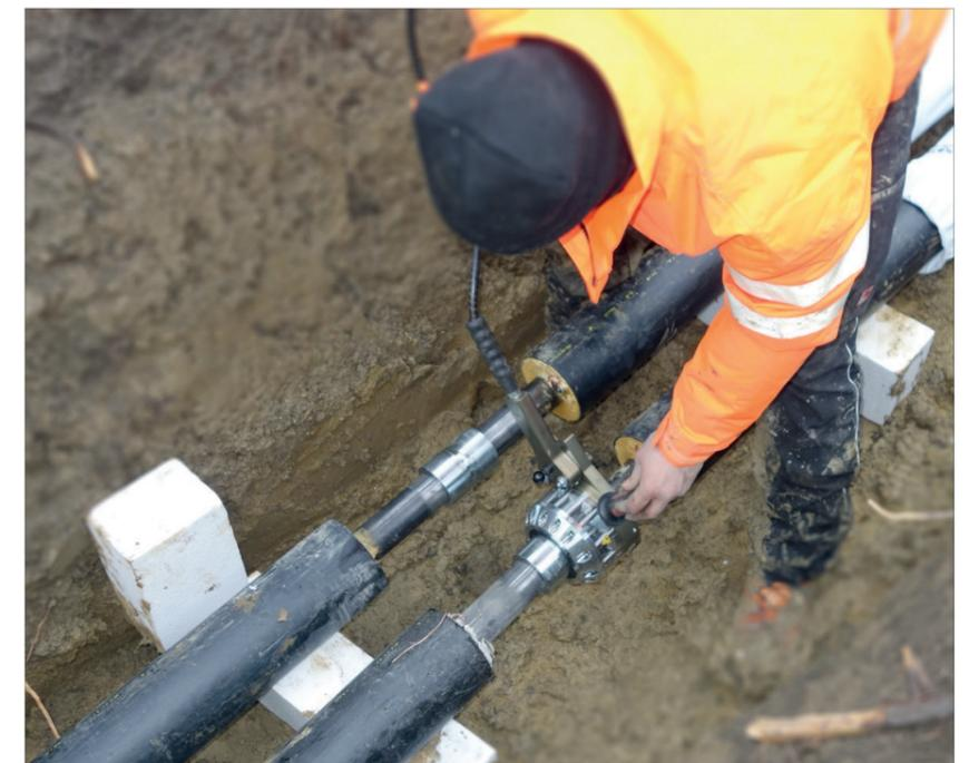
Bild 3. Einfache Handhabung auch mit in Betrieb befindlichen Leitungen: das Montagepersonal kann in sicherer Umgebung risikofrei die Verbindungen durchführen
